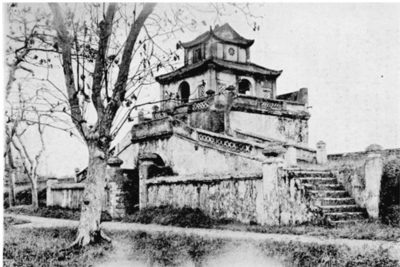
Planche LXV [ Photo IV ]. — Une porte ordinaire de la citadelle de Bắc-Ninh, La Porte Ouest, vue de l'intérieur, en l'état actuel. ( Cliché de l'Ecole Française d'Extrême-Orient ).
